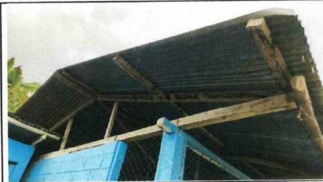
Foto 4: Módulo I, Sustitución de láminas troqueladas, costaneras y tijeras galvanizadas
