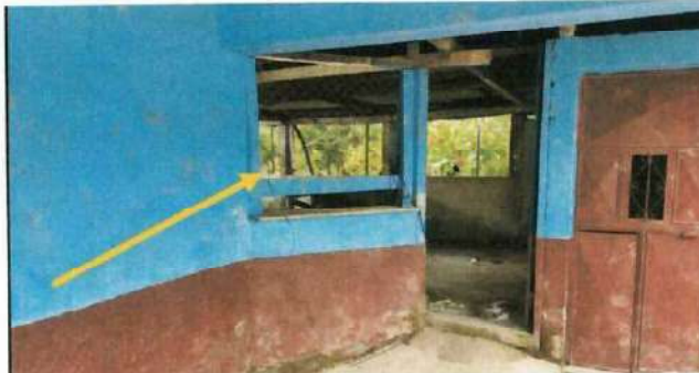
Foto 6: Módulo I, Sustitución de balcón
