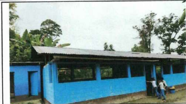
Foto 1: Módulo III, sustitución de láminas troqueladas, costaneras y tijeras galvanizadas chapa 16
