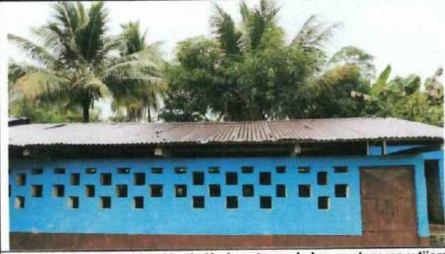
Foto 2: módulo II, sustitución de láminas troqueladas, costaneras y tijeras galvanizadas chapa 16
