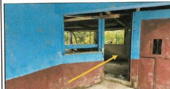
Foto 5: Módulo I, Sustitución de Puerta de metal
