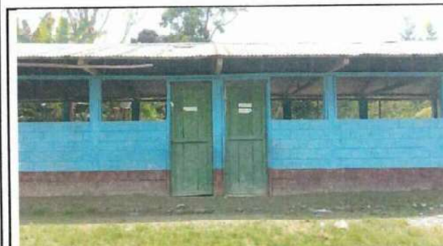
Foto 3: Módulo II, Sustitución de puertas de metal
